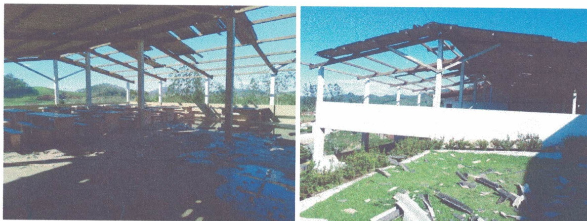
Igreja São Sebastião na localidade de Rio do Peixe, Município de Luiz Alves/SC
